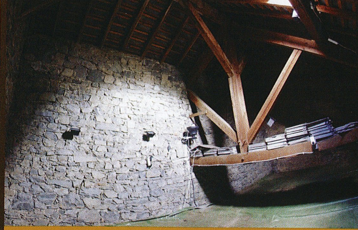
Matériels de vidéosurveillance dans les combles (cliché P. Saulay).
